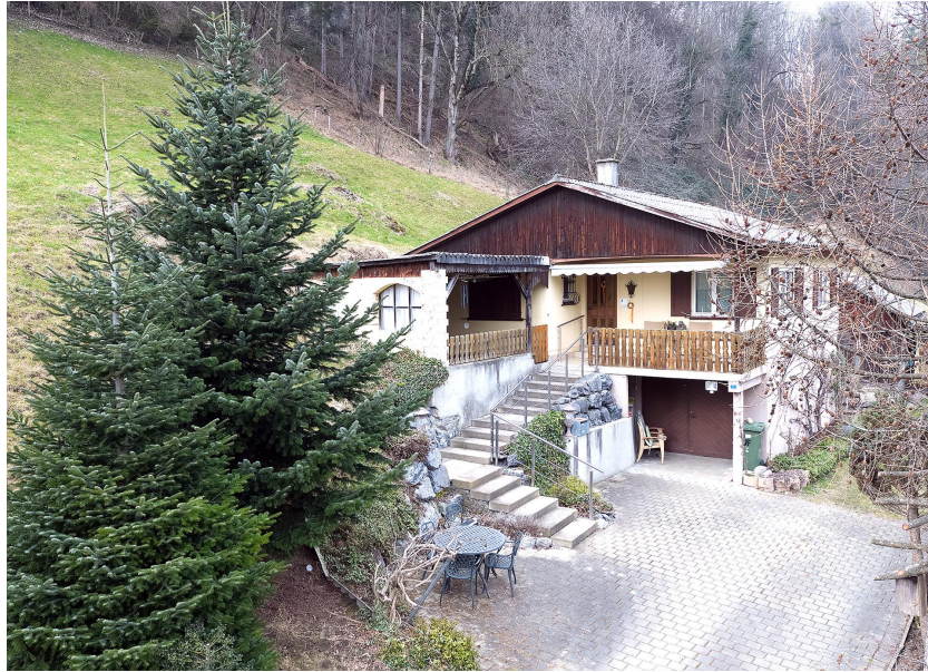
Wohnhaus Halde, Weite
